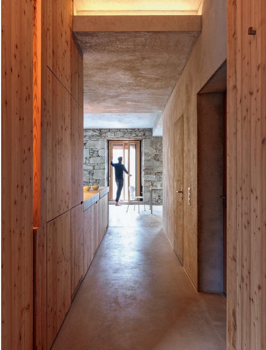
Leichtbauten und Einbaumöbel aus roher Fichte. Der Rohzustand ist eine Hommage an das Material.
